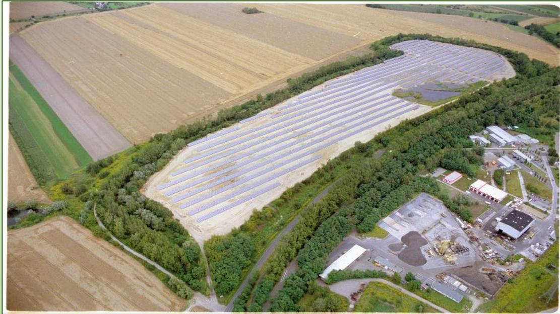
2004: „Größtes Solarkraftwerk“ mit 5MWp 32.724 Module á 150Wp, monokristalin
