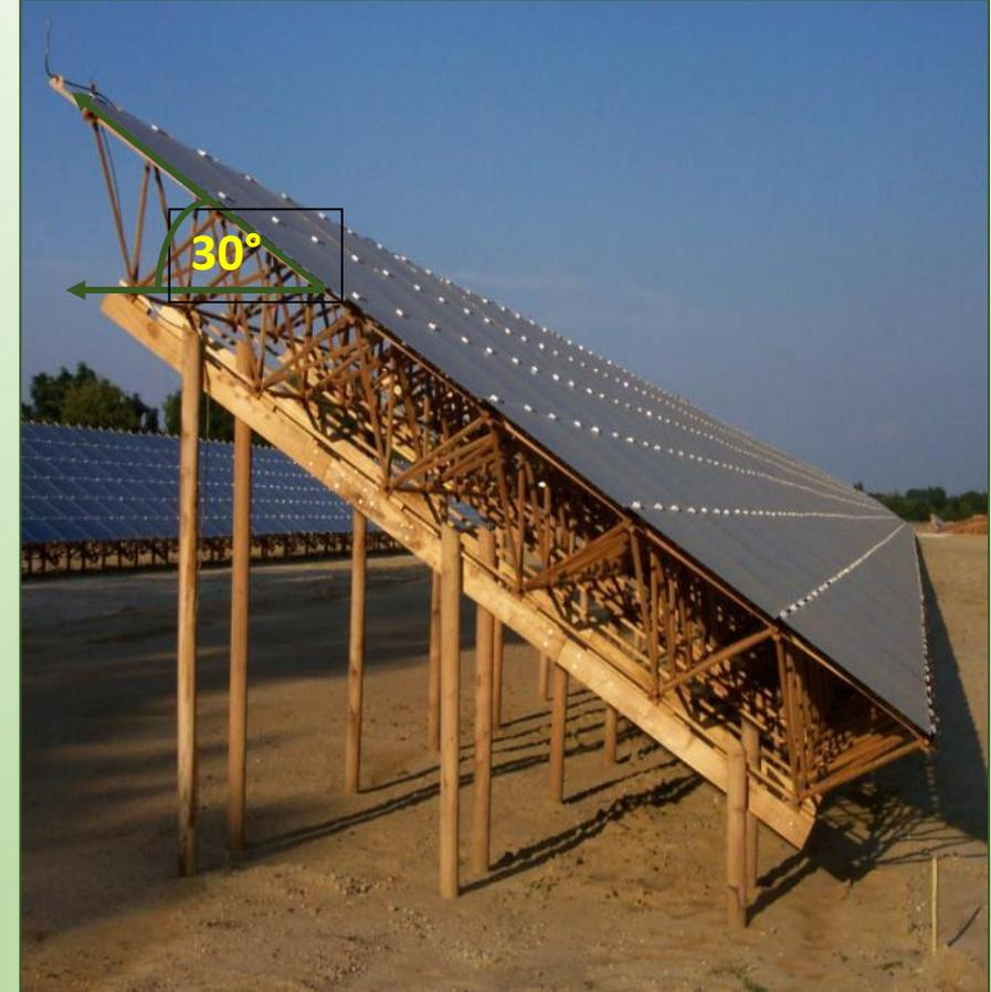
2006: Solarpark Borna, Fabrikstraße 3,44MWp 438 Solar Mover, Tracking System astronomisch
